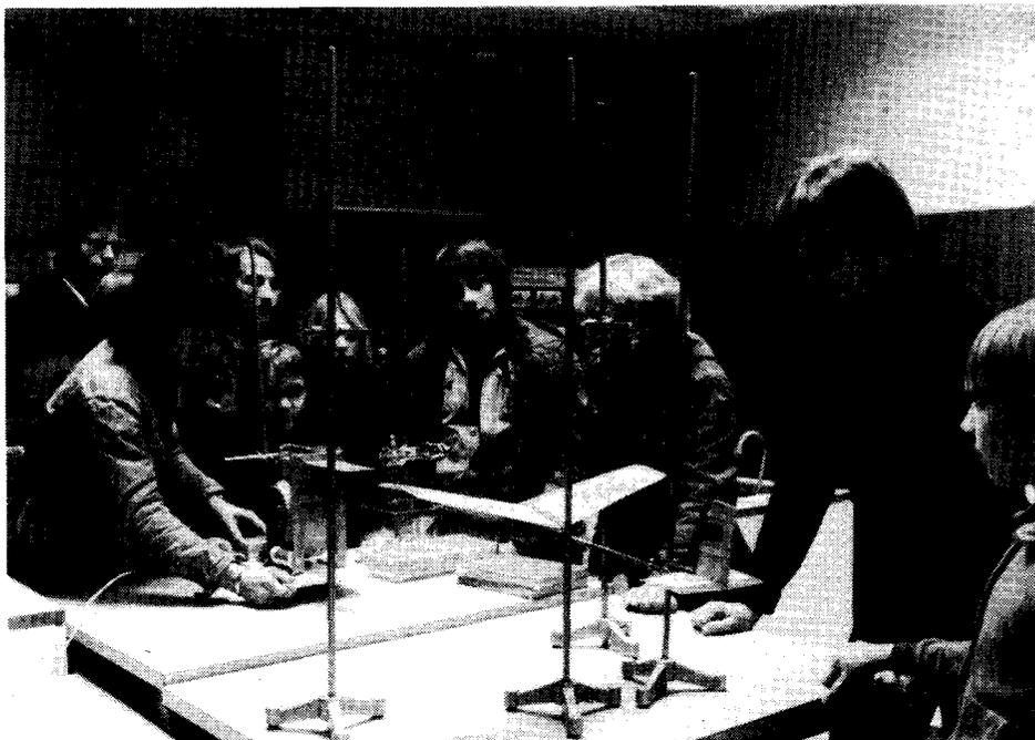
Die angeströmten Flugzeuge werden, wie an den Federwaagen abgelesen wurde, deutlich leichter. Bei dieser einfachen Anordnung hängt allerdings die Größe des Auftriebs von der Stellung des Flugzeuges im Luftstrom (Entfernung Flugzeug - Winderzeuger, Anstellwinkel) ab. Obwohl die Anordnung einige Mängel hatte (z.B. der Luftwiderstand, der sich auch als Zug auf die Kraft (Federwaage) auswirken kann), hatte der Versuch für die Schüler eine große Erklärungsmächtigkeit.
