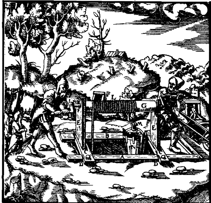
Der vorn am Schacht verlegte Pfühlbaum A. Der hinten am Schacht verlegte Pfühlbaum B. Die zugespitzten Pfähle C. Die Querhölzer D. Die Haspelstützen E. Die Pfadeisen F. Der Rundbaum G. Seine Zapfen H. Das Holz I. Die Kurbel K. Das Förderseil L. Der Seilhaken M. Das Fördergefäß N. Sein Bügel O.
