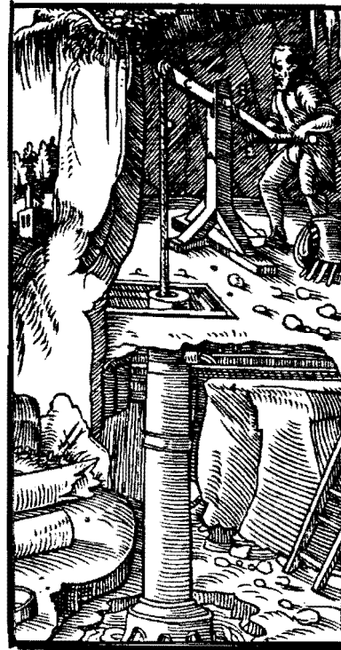
Arbeiter an der Entwässer- pumpe (Agricola, S. 149)
