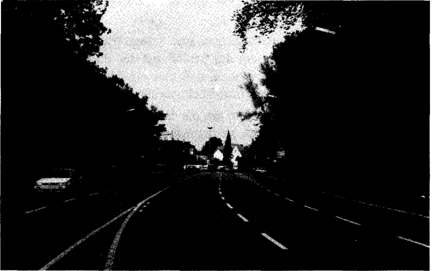
Ehemalige Wallpromenade - jetzt Stadtautobahn
